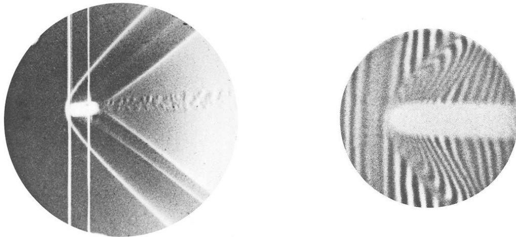
FIGURE 6.1 – Image prise par Ernst Mach (hiver 1888) d'une onde de choc devant un projectile supersonique (les traits verticaux sont des fils permettant la synchronisation de la prise d'image). Cinq ans plus tard, l'image de droite fut prise par son fils Ludwig avec un interféromètre de Mach-Zehnder pour quantifier le ressaut en pression.
